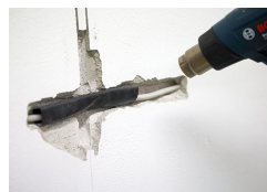
Schrumpfschlauch erhitzen und Schadstelle wieder fachgerecht verschließen.
