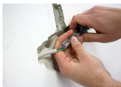
Leitung mit Leitungsreparaturset verbinden.
