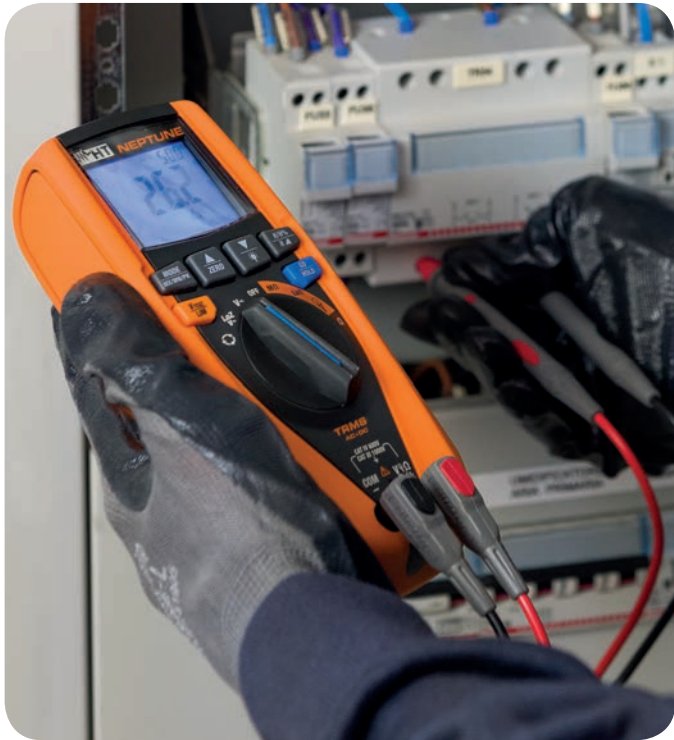
Spannungsmessung mit Messleitungen.
