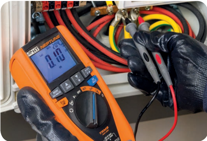
Durchgangsprüfung von Schutzleitern.
