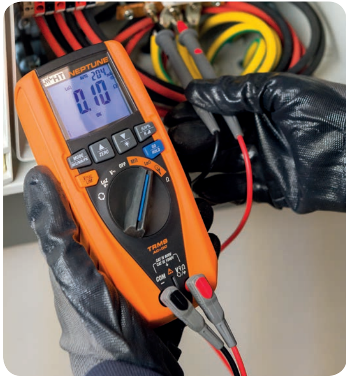
Durchgangsprüfung von Schutzleitern mit 200mA.
