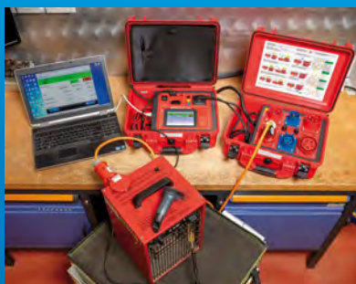
Prüfung eines 3-phasigen Heizlüfters
