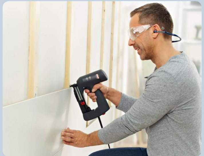
Profilhölzer mit Profilholzkralen befestigen.
