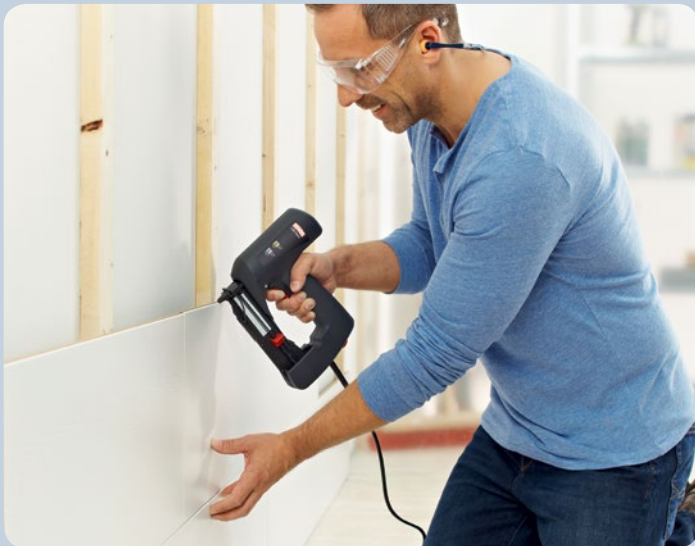
Direktes Befestigen von Profilhölzern.
