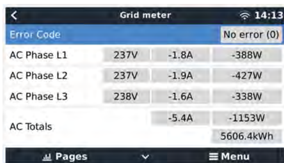
Detaillierte Übersichtsseite eines dreiphasigen Netzzählers
